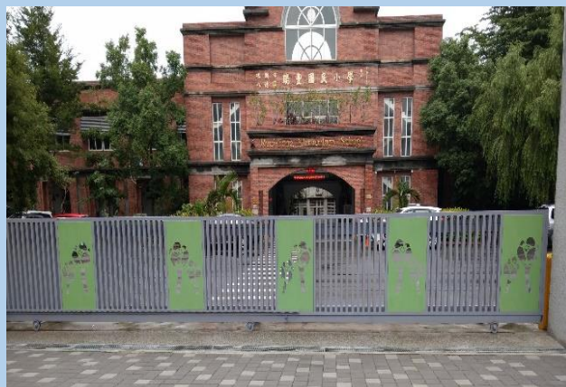
造型軌道大門、地坪高壓混凝土磚及沖孔鋁板烤
